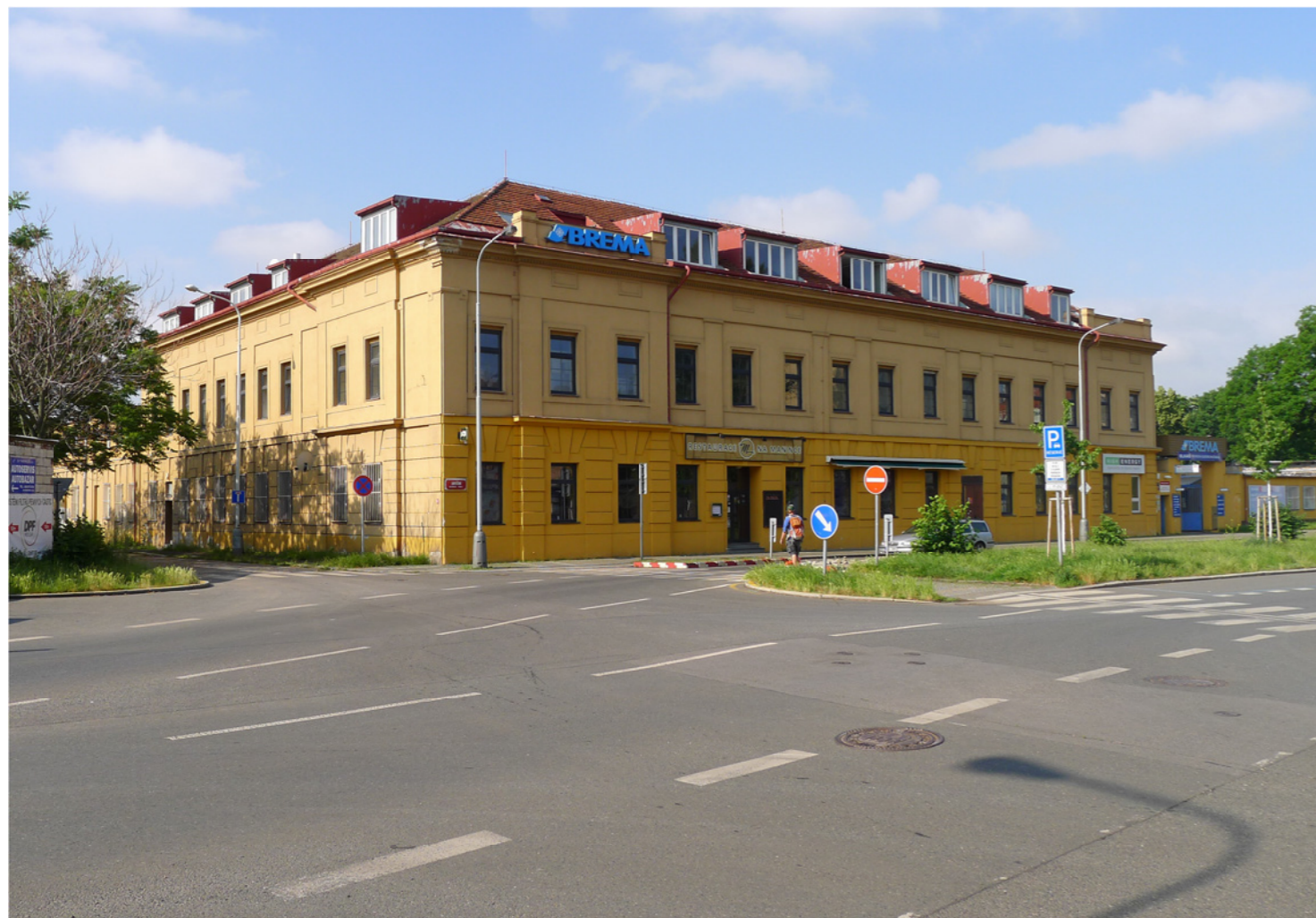
Holešovice - dům na nároží Jateční ulice
