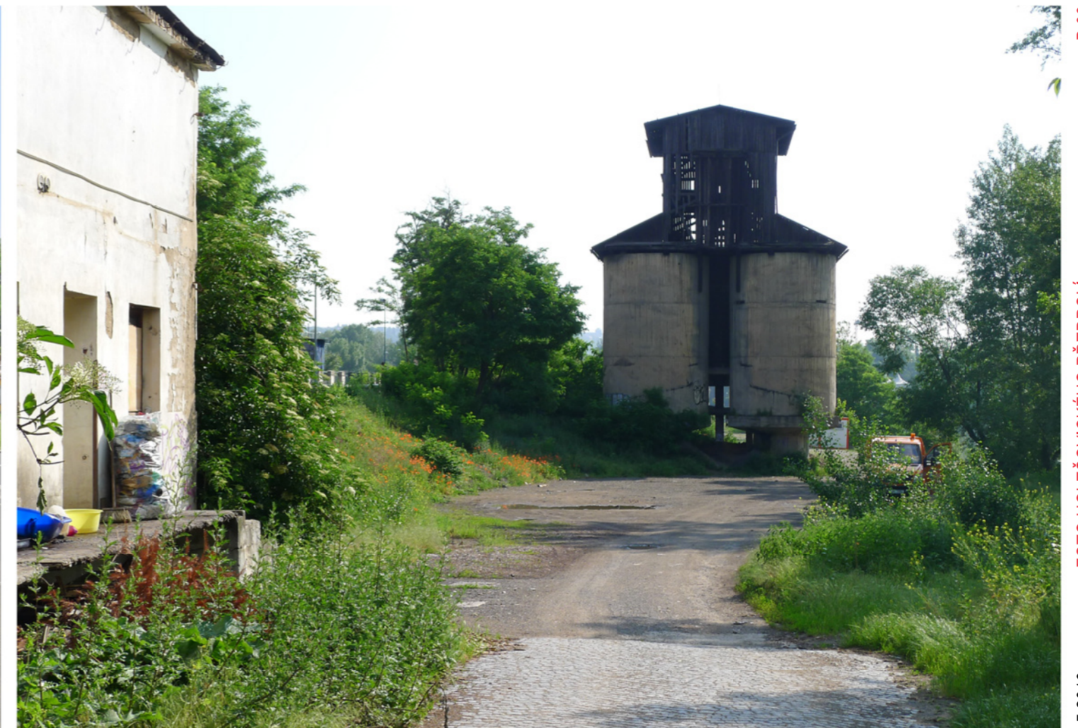
Holešovice - betonové silo na břehu řeky
