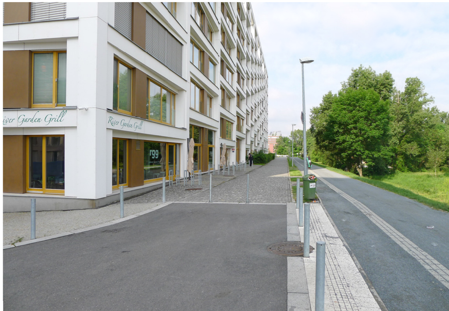
Karlín - nároží nové zástavby a úroveň protipovodňové hráze v podobě cyklistické stezky
